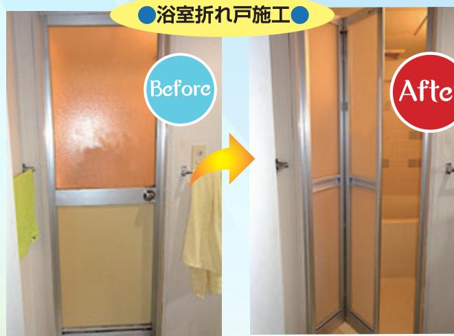
内開きから折れ戸に交換施工。施工後、折れ戸により開閉動作がスムーズになり、スペースも保持される。
